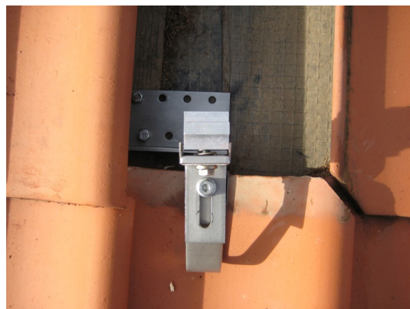
Her er anvendt UNIVERSAL BESLAG, og at det er muligt at forskyde beslaget, så det kommer ud lige i bunden af tagstenen, selv om spæret står placeret lige i samlingen mellem to tagsten.
