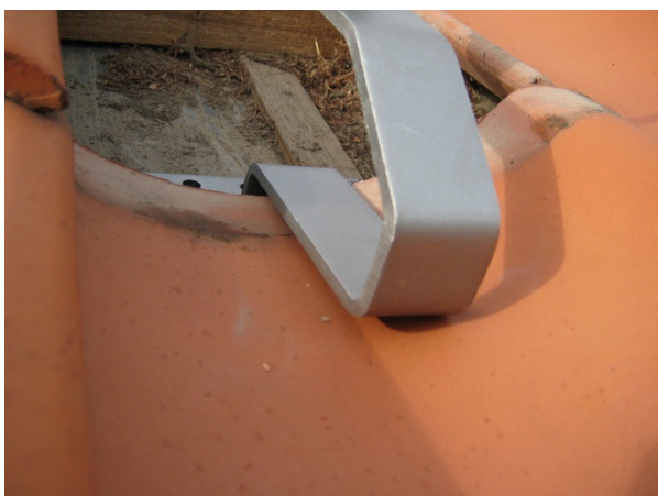
Sørg for at beslaget sidder pænt ned til tagstenen og ikke spænder ned på tagstenen. Hvis tagstenen sidder i spænd, så skal der anvendes en 2 eller 5 mm. GRØN afstandsstykke. Anvend det antal afstandsstykker der er nødvendigt for at undgå at tagbøjlen spænder ned på tagstenen.
