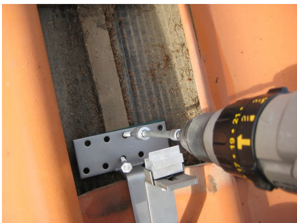
Fastgør beslaget til spæret med 2 stk. A2 stålskruer (De viste skruer afviger i udseende).
