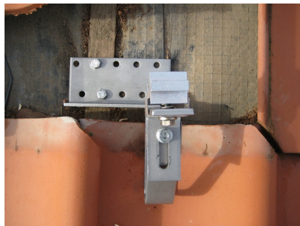
Hvis spæret står lige i samlingen mellem to tagsten, så kan man ikke anvende et almindeligt Rapid 2+ beslag. Der skal i stedet benyttes et UNIVERSAL BESLAG, hvor man har mulighed for at forskyde beslaget til siden.
